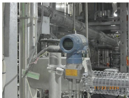
รูปที่ 63 ระบบวัดอุณหภูมิและความดันภายในถังปฏิกิริยาโพลีเอทิลีน PPG (PPG Reactor)
