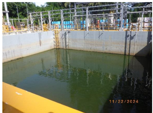
รูปที่ 20 บ่อพักน้ำเสียสุดท้าย (Final Check Basin)
