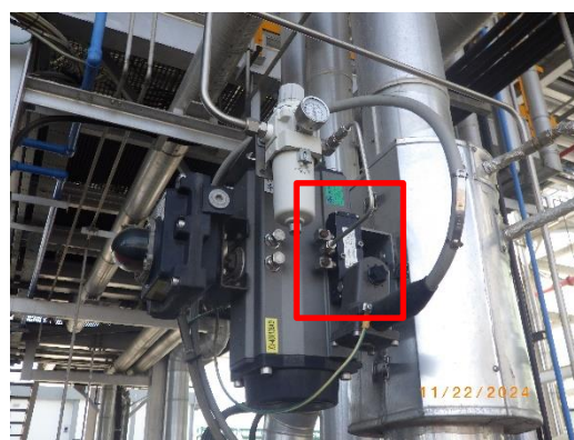
รูปที่ 12 การติดตั้งอุปกรณ์ลดเสียง
