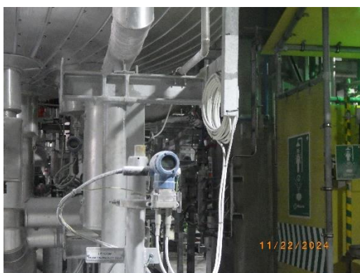
รูปที่ 63 ระบบวัดอุณหภูมิและความดันภายในถังปฏิกิริยาโพลีเอทิลีน PPG (PPG Reactor)
