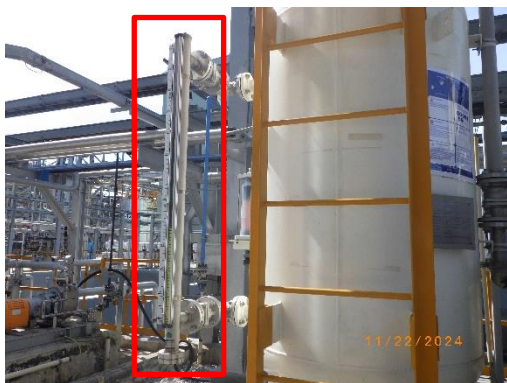
รูปที่ 59 อุปกรณ์วัดระดับ (Level Indicator) ของสารเคมีในถังเก็บ และสัญญาณเตือน (Level Alarm)
