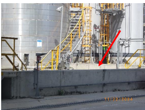
รูปที่ 55 คันกัน (Bund) ล้อมถังเก็บสารเคมี
