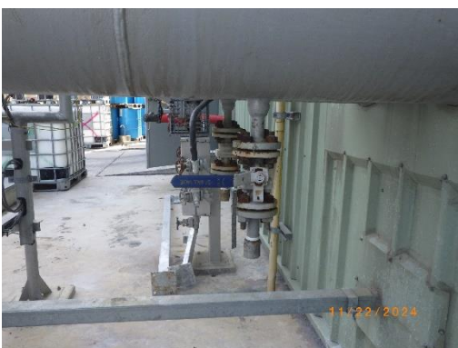
รูปที่ 8 ฝาปิด (Cap or Plug or Blind Flange) สำหรับท่อปลายเปิดทั้งหมด
