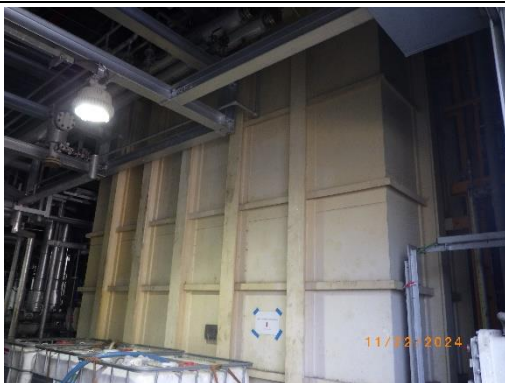
รูปที่ 17 บ่อรวบรวมน้ำเสียที่มีความเข้มข้นของ มลสารสูง (POP/Premix High Polluted Wastewater Pit; HPW Pit)
