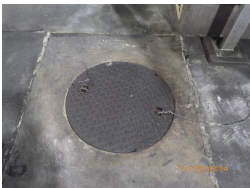
รูปที่ 10 บ่อรวบรวมน้ำเสียที่มีความเข้มข้นของมลสารสูง (PPG High Polluted Wastewater Pit; HPW Pit)
