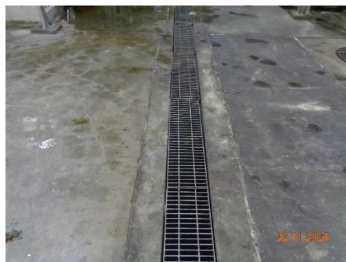
รูปที่ 26 รางระบายน้ำฝน และรางระบายน้ำเสีย
