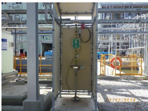
รูปที่ 48 อ่างล้างตาและร่างกาย กรณีฉุกเฉิน
