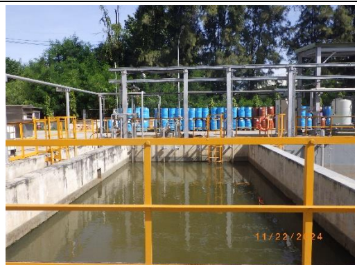
รูปที่ 18 บ่อพักน้ำระบายทิ้งจากหอหล่อเย็น (Cooling Water Blowdown Hold Sump)
