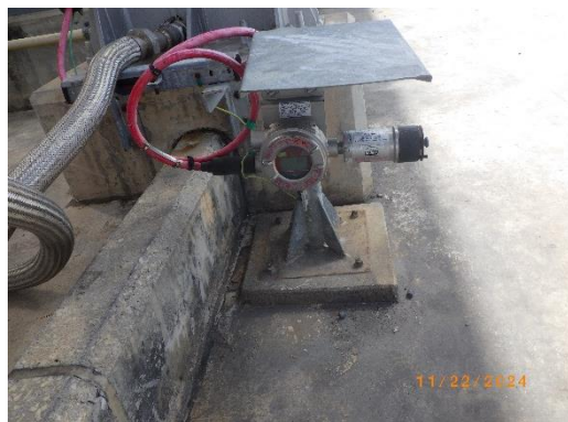
รูปที่ 59 อุปกรณ์วัดระดับ (Level Indicator) ของสารเคมีในถังเก็บ และสัญญาณเตือน (Level Alarm)
