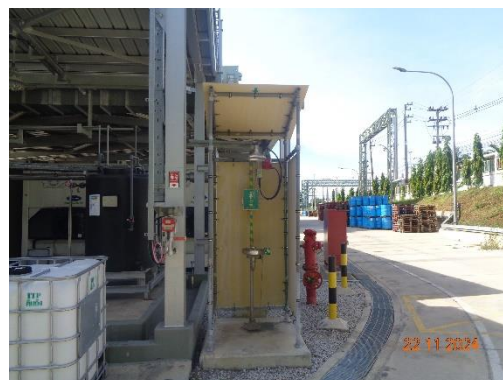
รูปที่ 48 อ่างล้างตาและร่างกาย กรณีฉุกเฉิน
