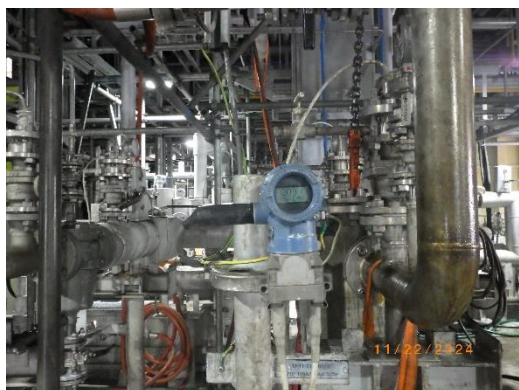
รูปที่ 64 ระบบวัดอุณหภูมิและความดันภายในถังปฏิกริยาฟอสฟอรัสชนิด POP (POP Reactor)
