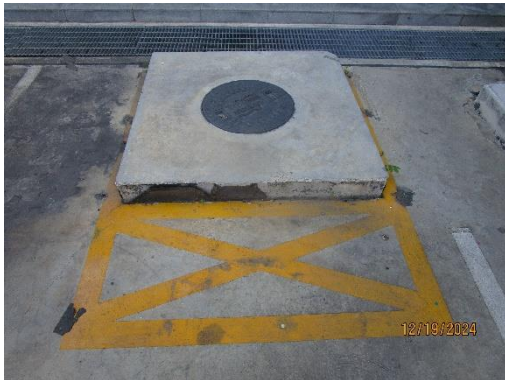
รูปที่ 15 ถังบำบัดน้ำเสียสำเร็จรูป (Septic Tank)
