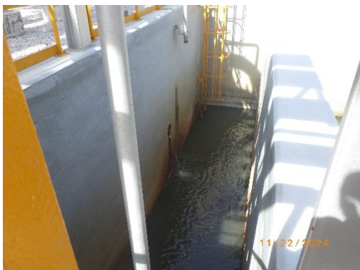
รูปที่ 21 หน่วยแยกน้ำมัน (Oil Separator)
