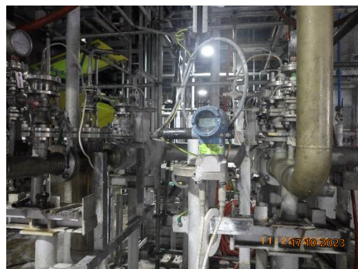
รูปที่ 64 ระบบวัดอุณหภูมิและความดันภายในถังปฏิกริยาฟอสฟอรัสชนิด POP (POP Reactor)
