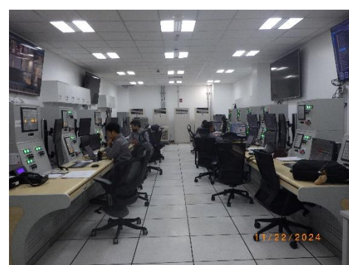
รูปที่ 56 ระบบ Distributed Control System (DCS)
