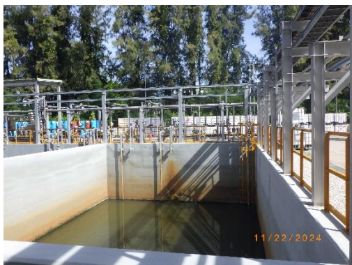
รูปที่ 19 บ่อรับน้ำเสียฉุกเฉิน (Emergency Wastewater Retention Basin)
